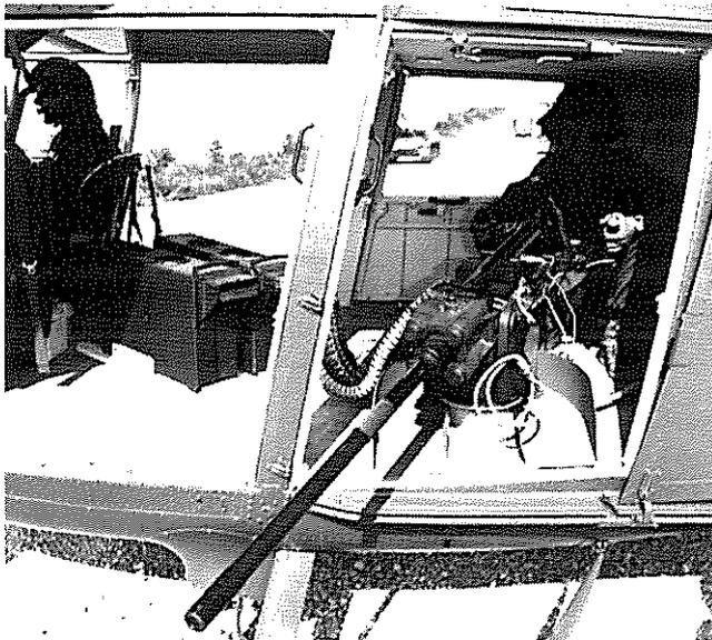
Fig. 13a : MG151 20 mm SIDE-MOUNTED CANNON
