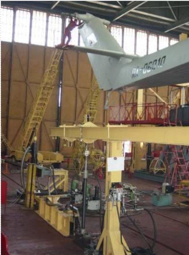
Установка ложной втулки
