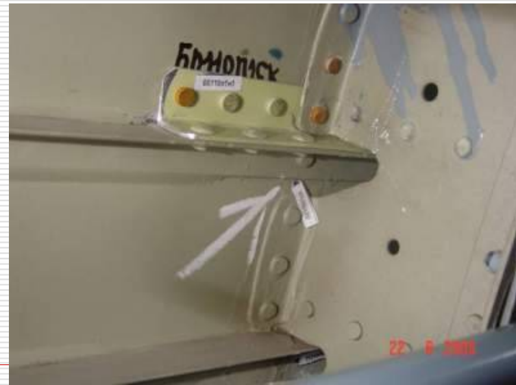
ремонтная наклейка через шпангоут
