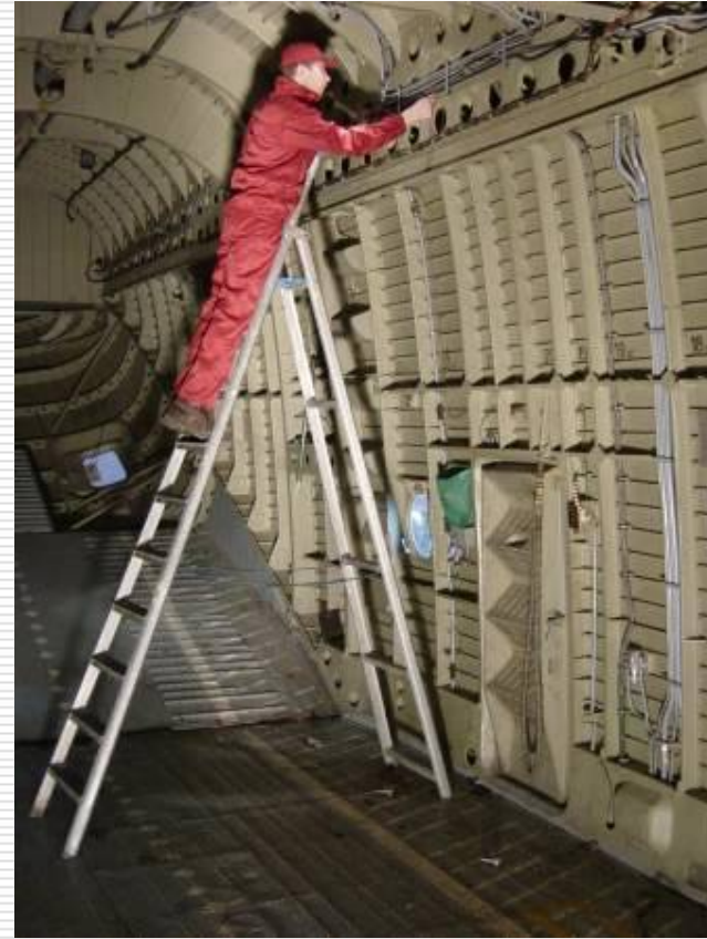
Подготовка трасс систем сбора информации
